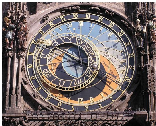
Obr. 1 Astronomický ciferník pražského orloje před rekonstrukcí. Uprostřed je znázorněná Země a kolem ní jsou koncentricky umístěny tři kružnice reprezentující postupně od středu obratník Kozoroha, nebeský rovník a obratník Raka doplněný římskými čísly. Foto: Michal Křížek
