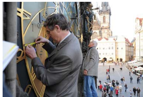
Obr. 7 Měření šířky prutu zlatené kružnice obratníku Raka. (Foto: Ivana Macourková)
